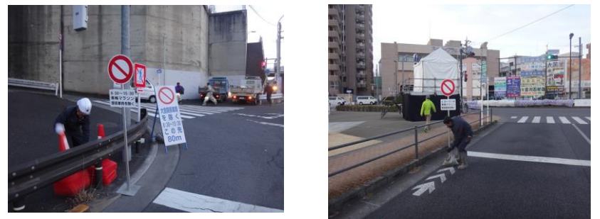
設置作業の様子
