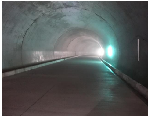
トンネル内部状況
