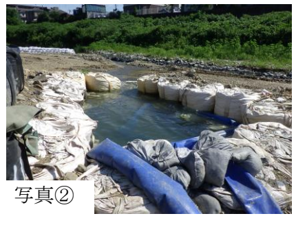
写真① 熱中症対策 表示板 写真② 汚泥対策 沈殿槽 写真③ パトロール風景
