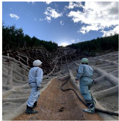
写真タイトル: 「完成した現場を見上げ、一安心する2人」
