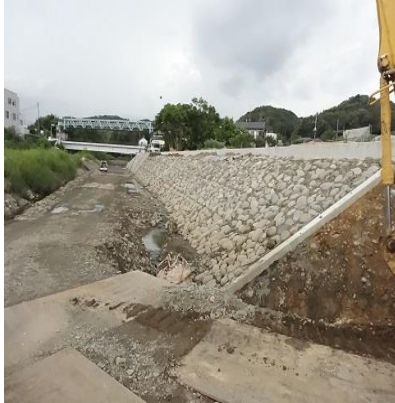
平井川整備工事
