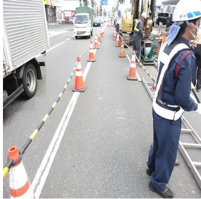
電線共同溝設置工事
