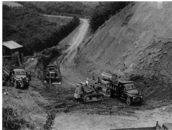
写真① 二ツ塚道路改修工事
