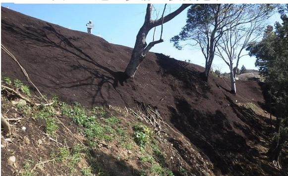
上図 施工後 植生基材完了
