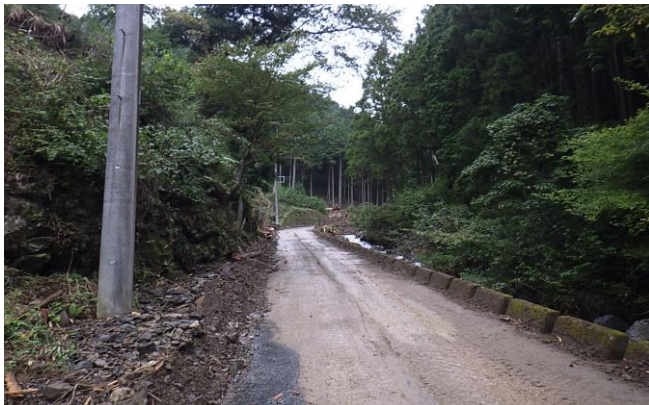
（下図 現場その2写真 災害発生直後）
