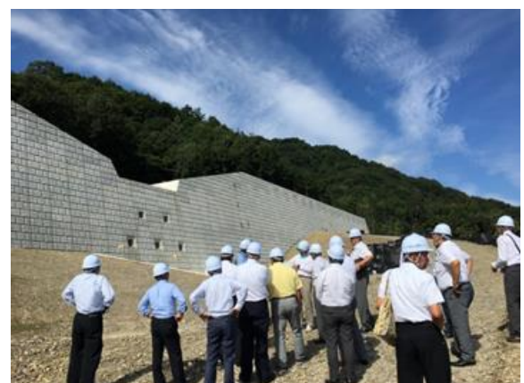
整備された阿武の里2号砂防堰堤（提高11m、堤長さ186m）
