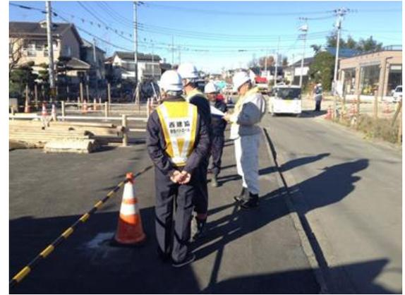
現場内外の整理整頓・清掃に行き届いている現場でした。施工箇所と一般者の通路との区画が明確にされていて、路面はしっかりと清掃されていました。現場付近の上空には三角旗で架空線の接触防止にも努めていました。
