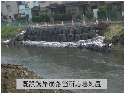
既設護岸崩落箇所応急処置
