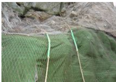
改善後、保護具設置完了
